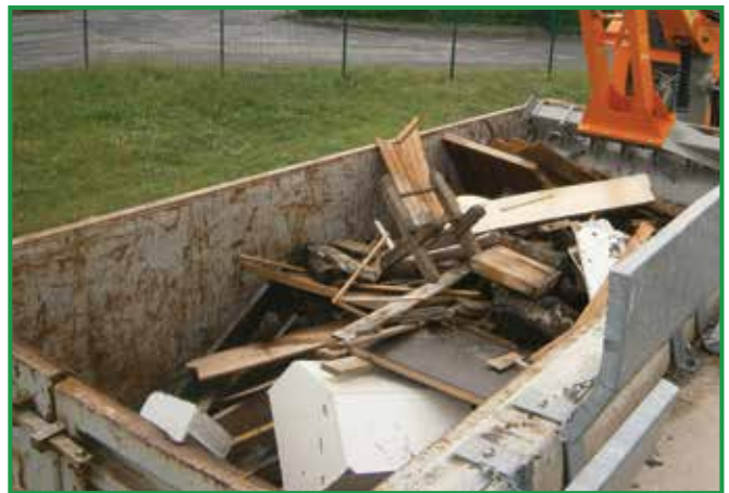
Avant le passage du rouleau compacteur
